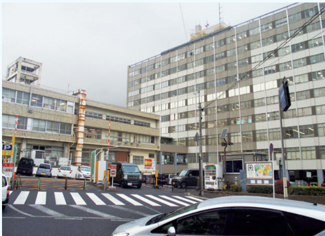
駐車場側から見た市庁舎(本館・新館)
