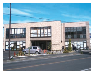
明市民センター外観
